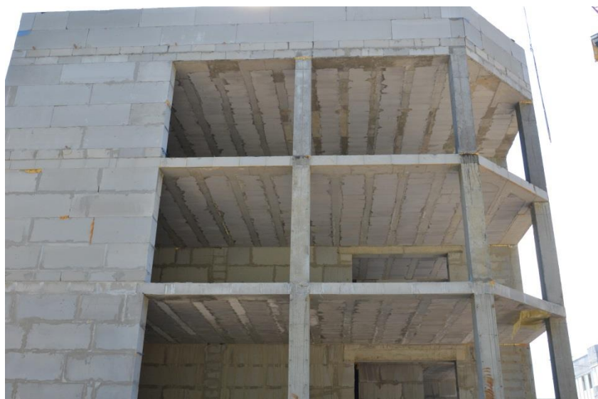
Фото 4. Принцип «одного поддона» в реализации
