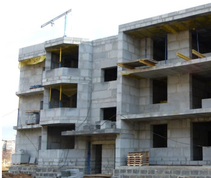
Фото 1. Наружные стены выполнены из укрупненного твинблока
